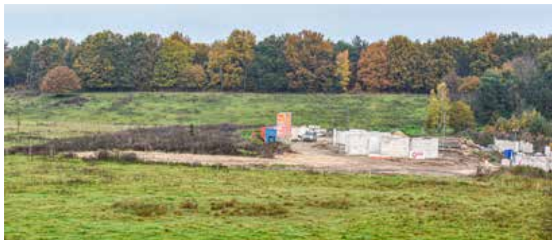
De acht woningen in aanbouw, november 2019.
