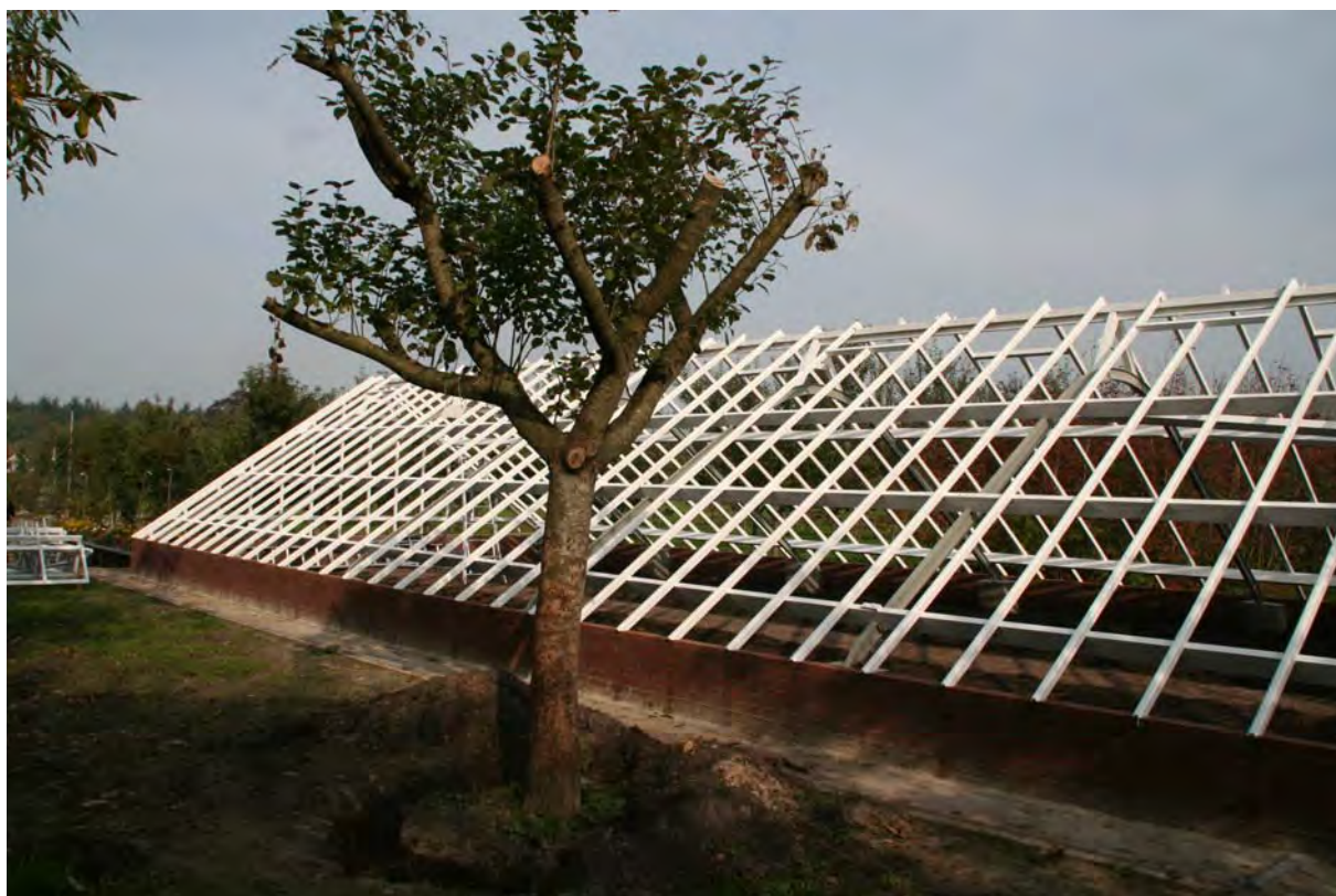
De nieuwe druivenkas van de Fruithof in aanbouw.
