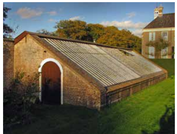
19e-eeuwse dubbele druivenkas, opgesteld als een lessenaar tegen de 18e-eeuwse tuinmuur. Foto Friesburg.
