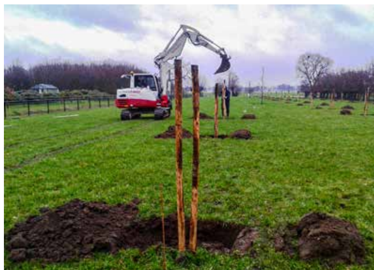
Bij de aanleg van een boomgaard gaat het gaten graven en palen zetten heel snel met een minigraver.
