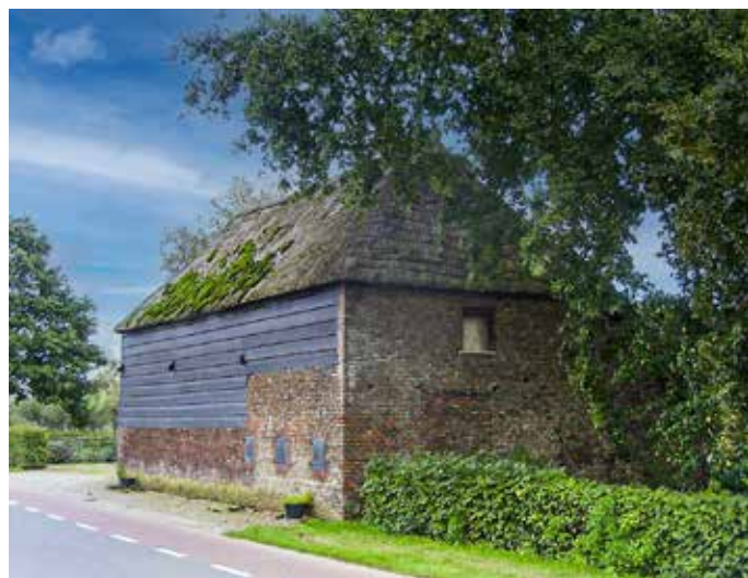
De voormalige tabaksschuur in Herveld, Tielsestraat 157.
