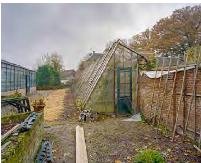
Overzicht glasopstand van een oude muurkas tegen een fruitmuur in restauratie.
