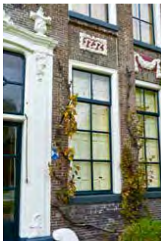
De twee gevelstenen met het jaartal 1717.
